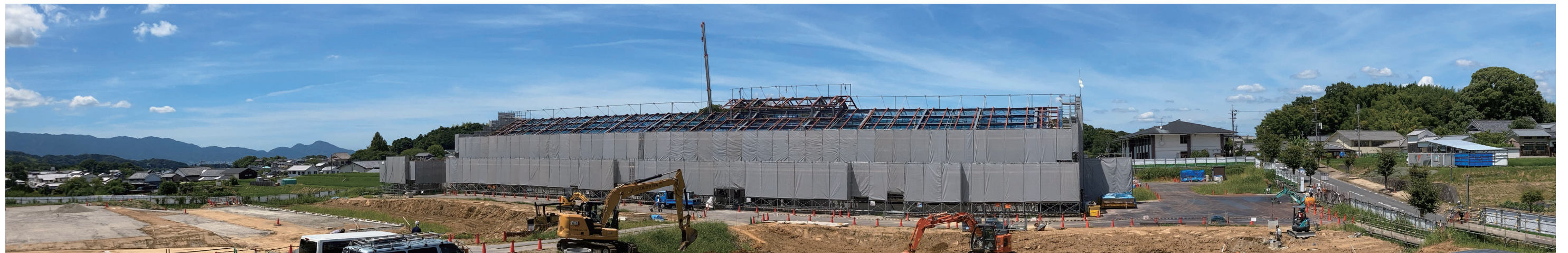
現場事務所から北向きに撮影
